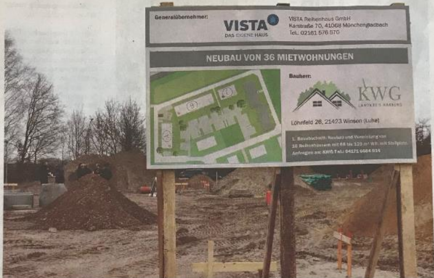
Die KWG errichtet im Baugebiet Norderbülte 16 Reihenhäuser und vier Mehrfamilienhäuser.
